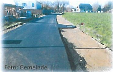
Am Bauhofweg wurde die notwendige Infrastruktur (Kanal, Wasser, Lichtwellenleiter, Ortsbeleuchtung) für die Aufschließung des vorhandenen Baulandes eingebaut. In diesem Bereich wurde die Asphaltdecke komplett erneuert und im Bereich der Fa. Waldland Teilflächen erneuert. Gesamtkosten am Bauhofweg ca. 85.000.-- Euro.
